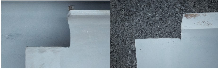
Figure 6. Mauvaises pratiques en matière de coupe de chape
